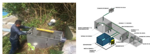
Figura 6 | Instalación del sistema de trampa de grasas Bombas sumergibles echadas a perder por falta de mantenimiento.
