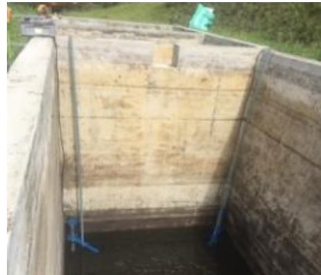
Figura 12 | Implementación de sistema de bombeo para evaluación de lodos.
