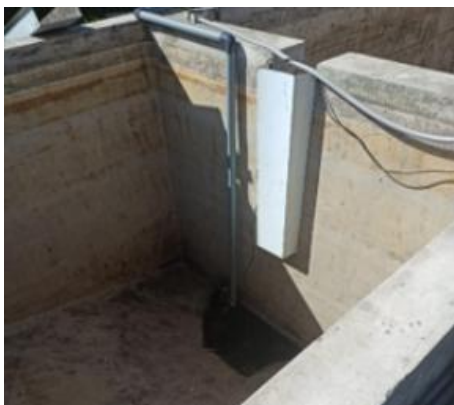
Figura 11 | Instalación del sistema deflector al ingreso y salida del reactor aerobio.
