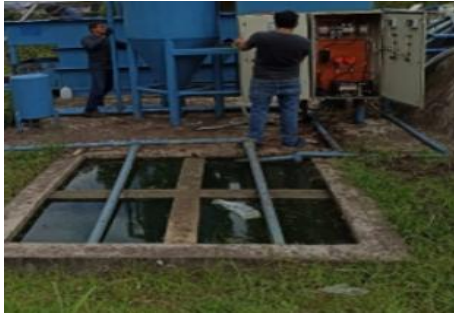
Figura 9 | Observación y mantenimiento del sistema eléctrico.
