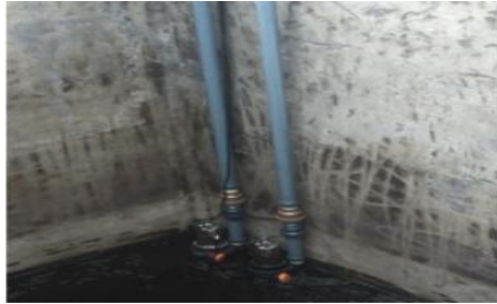
Figura 8 | Colocación de bombas sumergibles en el tanque de homogenización.
