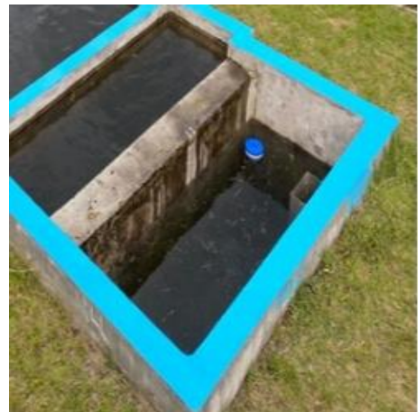
Figura 14 | Implementación de sistema de dosificación de cloro y colocación de sistema deflector en la cámara de contacto.
